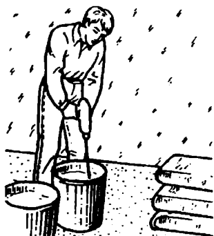
Подготовка наливной массы
