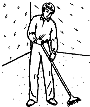
Очистка основания пола
