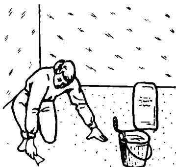
Шпатлевка основания пола
