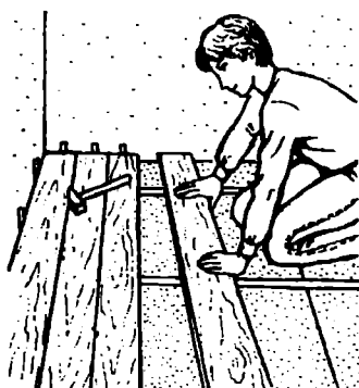
Укладка сосновых досок
