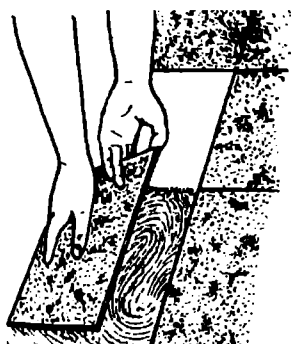
Плиты могут быть уложены одна за другой
