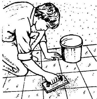
Окончательная очистка напольного покрытия
