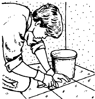
Удаление загрязнений с керамической плитки
