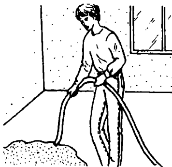
Смесь наносится перекачиванием
