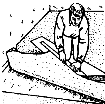
Раскладка покрытия и подготовка мест стыка
