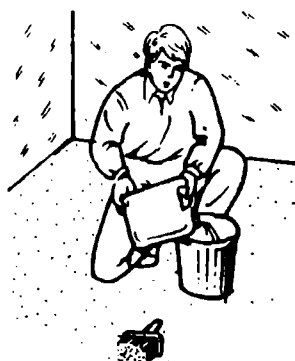
Грунтовка основания пола
