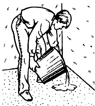
Приготовленную массу выливают, начиная от одной из стен
