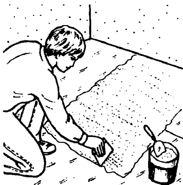
Шпатлевка стыков плит и утопленных в них головок шурупов
