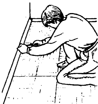
Установка плинтусов
