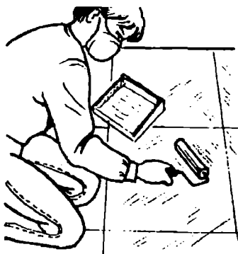
Покрытие поверхности паркетным лаком
