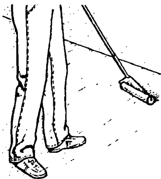
Покрытие пола лаком
