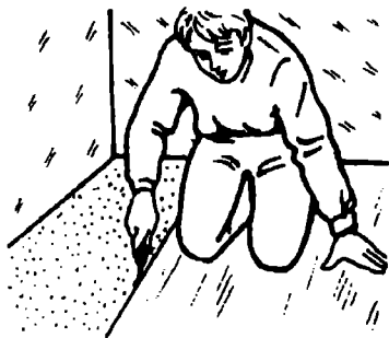
Вырезание канавки для шнура
